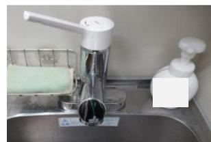
※手洗い水栓は、洗淨後、手指の再汚染を防止できる構造(レバー式、センサー式等)
