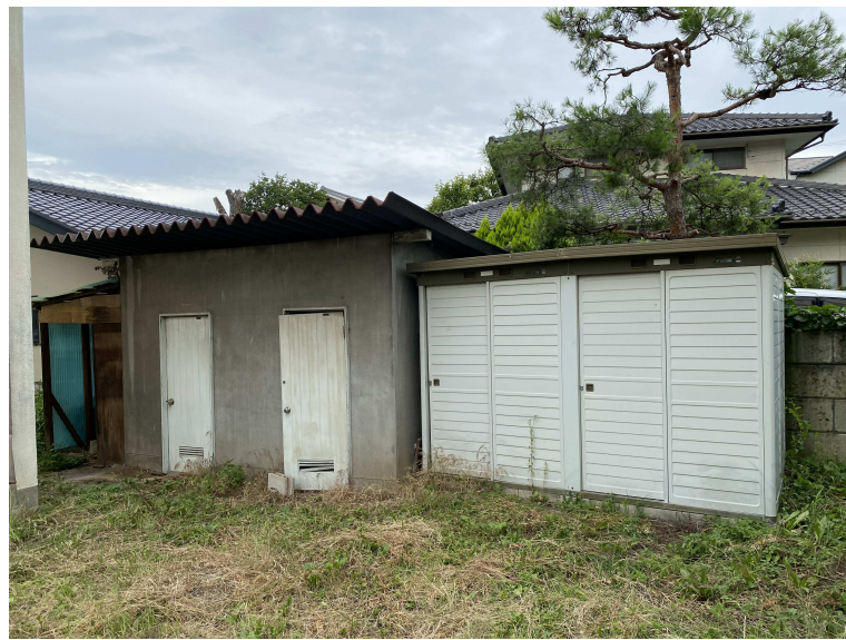
物置、ガスボンベ庫
