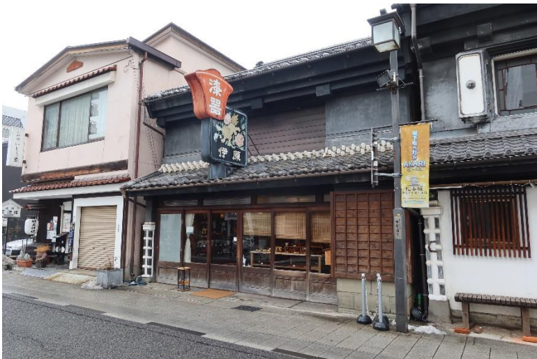
伊原漆器専門店店舗兼主屋 (南東から)
