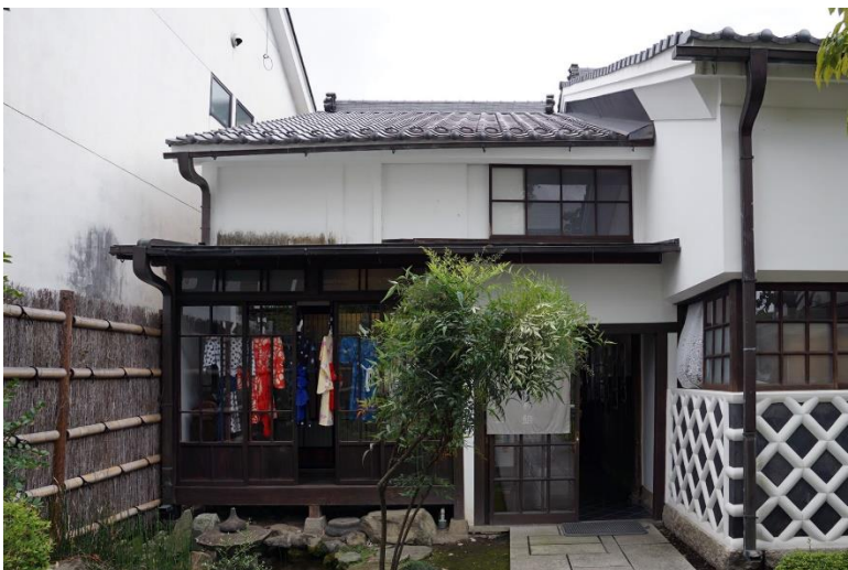
旧竹内度量衡店店舗兼主屋（松本市はかり資料館第一展示室）東棟（北から）
