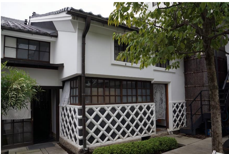
旧竹内度量衡店店舗兼主屋（松本市はかり資料館第一展示室）西棟（北東から）
