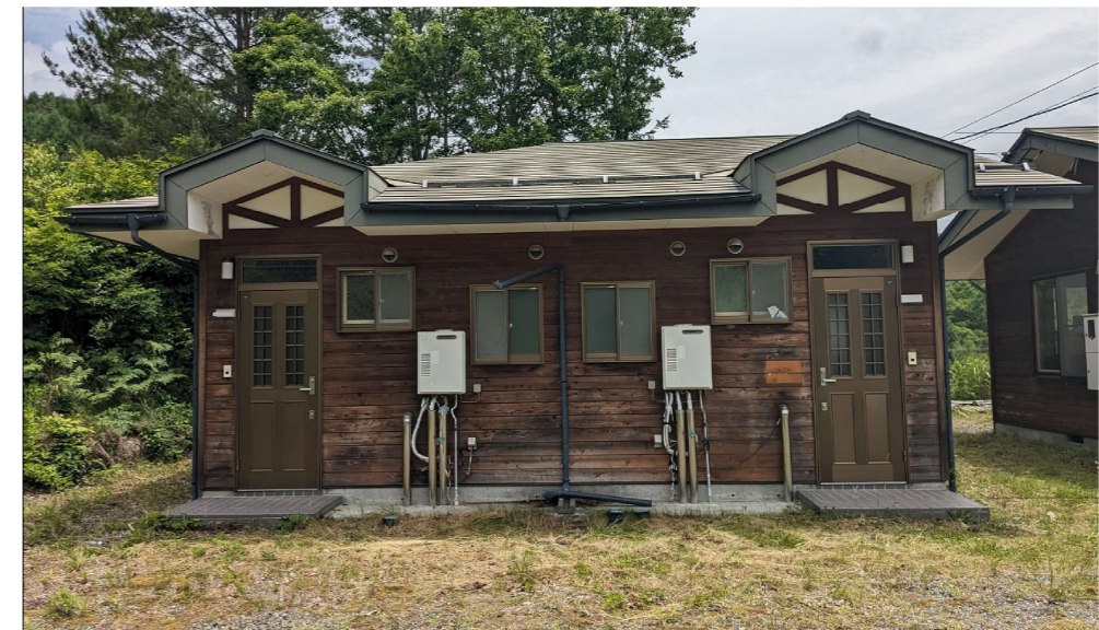
C棟 北立面写真 S=Non
