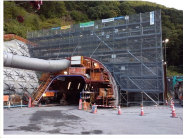
起点側坑門工
