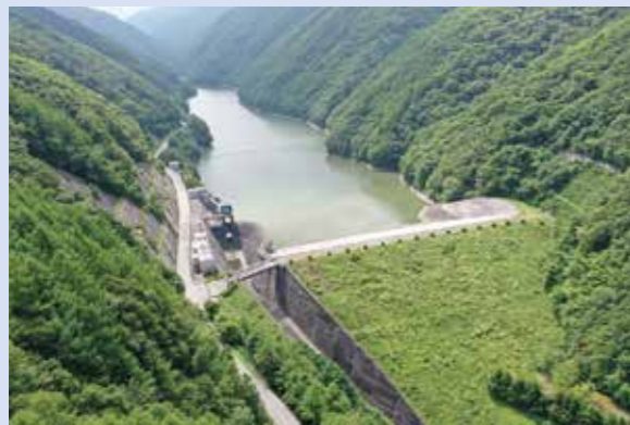
奈良井ダム (塩尻市奈良井)
