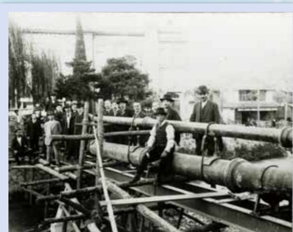
配水管布設工事 旧市役所前 女鳥羽川一ツ橋
