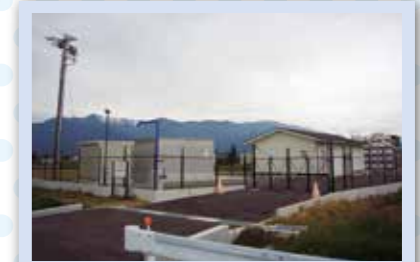
南大妻第1水源 (松本市梓川倭) 水源能力：1,500m 3 /日
