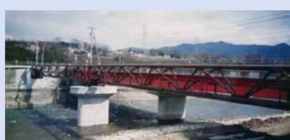
平成10年当時の桔梗大橋
