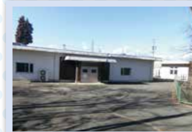
島内第2水源 (松本市島内) 水源能力：22,800m 3 /日
