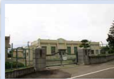
島内第1水源 (松本市島内) 水源能力：27,500m 3 /日
