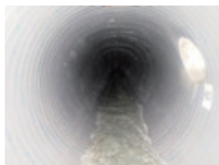
改修した下水道管の状況
