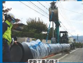
更新工事の様子
