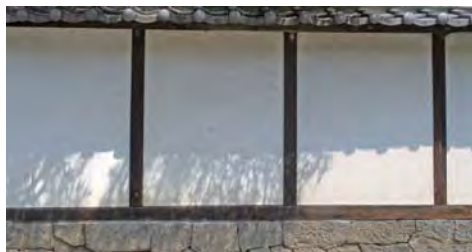
伝統的な瓦、漆喰、木、石の組合せ
