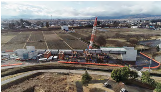
建設が進む中部縦貫自動車道
