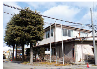
耐震補強工事が予定されている食肉衛生検査所
