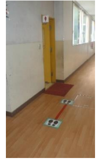
待機線を設けたトイレ出入口
