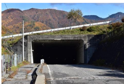
写真-2 雪見ヶ原トンネル全景
