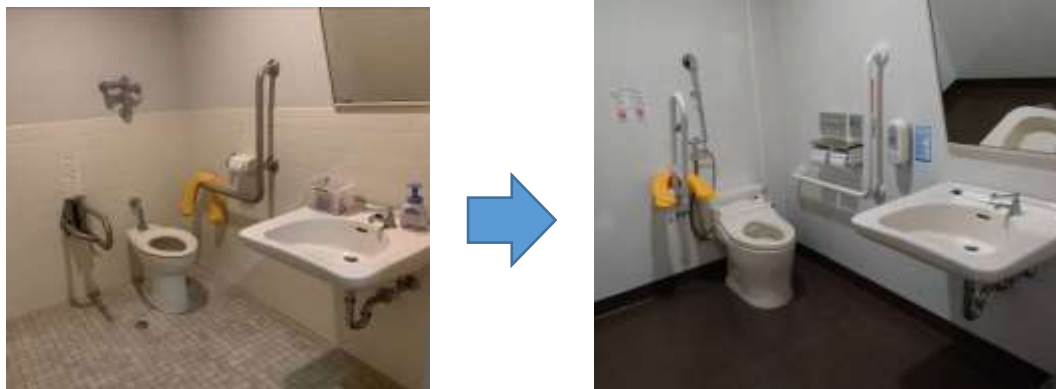
改修した小中学校多目的トイレ(令和3年度開智小学校)
