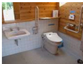
十分な広さの多目的 トイレ
