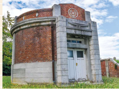
旧城山配水池 接合井
