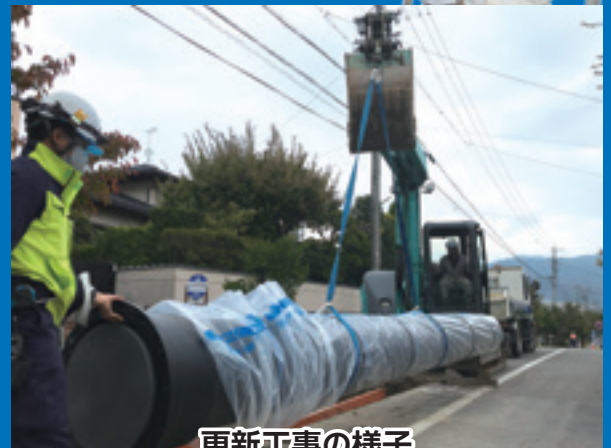
更新工事の様子
