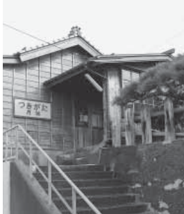
旧月潟駅舎外観
