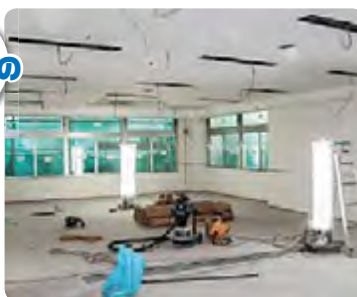
1F 和室を大会議室に改装している様子
