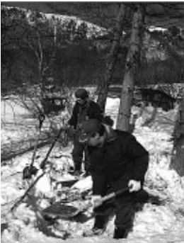
三城地区防火水槽の除雪
