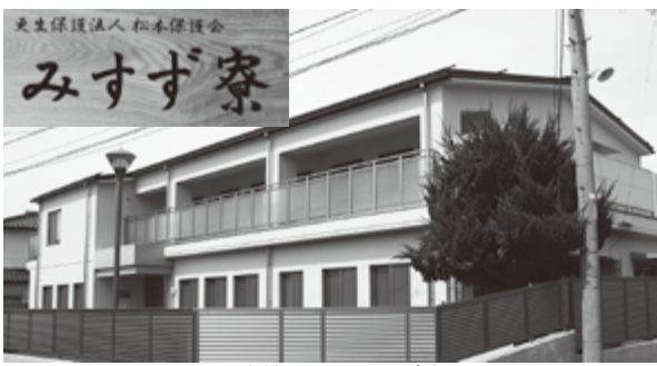
改築したみすず寮
