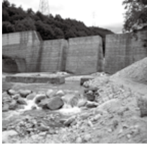
既設の乳川白沢砂防ダムスリット化改修 (2015年現在)
