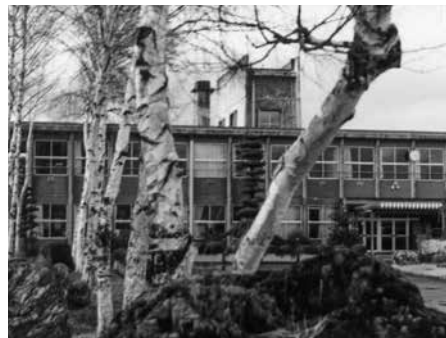
前校舎(昭和42年竣工)
