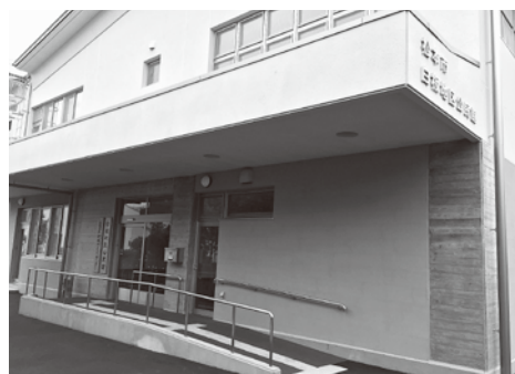
新築した白板地区公民館
