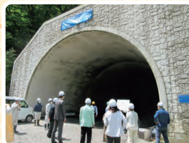
大白川トンネル
