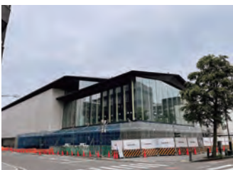
建設が進む基幹博物館
