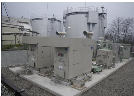
宮渕浄化センター消化ガス発電設備
