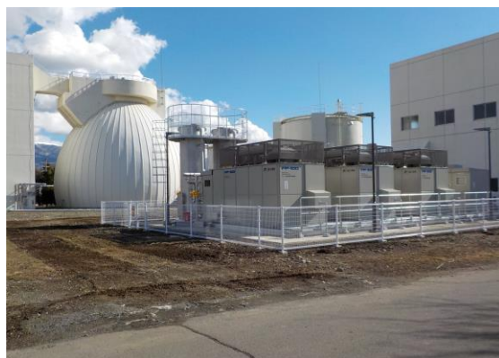
両島浄化センター消化ガス発電設備
