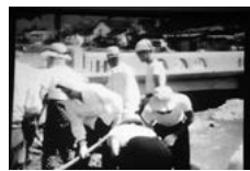
町内総出の復旧作業 女性も頑張る
