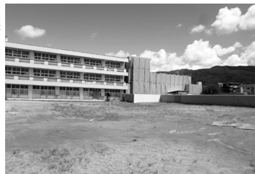
工事が進む増築棟 (右) と既存校舎
