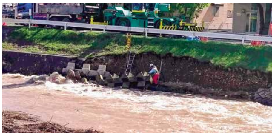
10月23日撮影 薄川端左岸の下流
