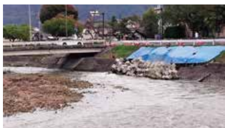
11月6日撮影 護岸への応急対策中
