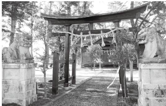
小宮神社鳥居の補修工事が終わりました
