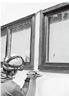
漆喰の外壁の塗り替えの様子
