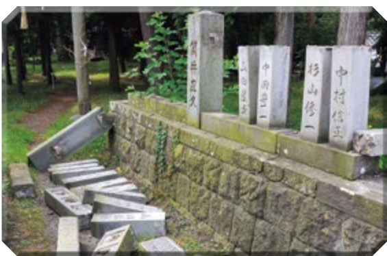
松本地震 多賀神社の被害状況
