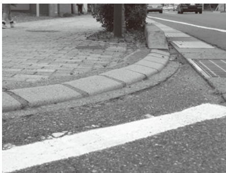
車道と歩道の段差
