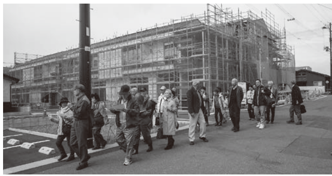
住宅が建設されるなど復興が進む現場を歩く
