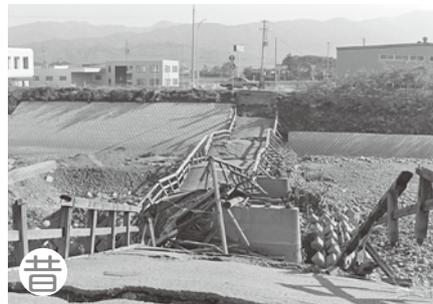
(1985.11 写真提供:日本報道写真連盟) 奈良井川の大水により川底が削り取られて、橋桁が落下して木製の橋が崩落。上二子橋は時々流されており、その都度修復した。奈良井ダムは1982年に竣工している。
