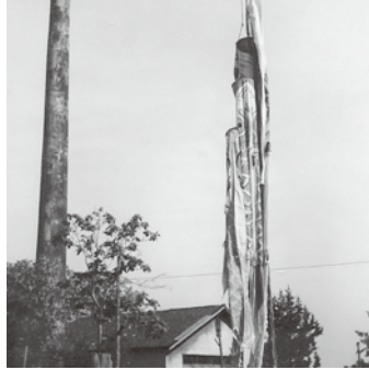
軍需工場宮田製作所宅の煙突
