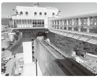
展望回廊からみた扉体
