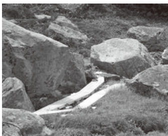
7月8日の豪雨による落石で木道が破壊され通行止め
