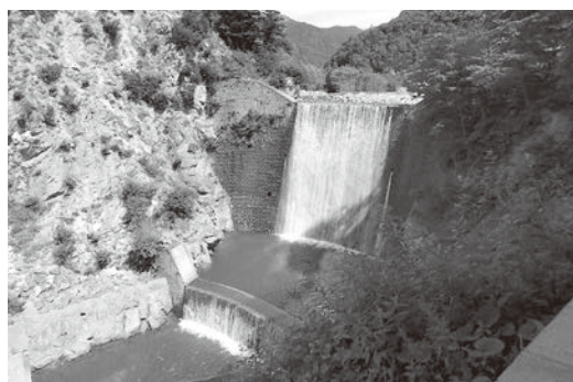
国の登録有形文化財 釜ヶ淵堰堤
