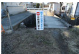
① 通行禁止看板・ 街区表示板
