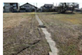
⑳ 畦畔ブロック（里道）
