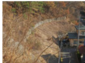
⑭ 治山施設
