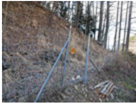
① 鳥獣被害防止防護柵ゲート
