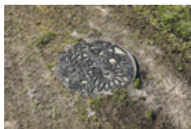
⑥ マンホール
