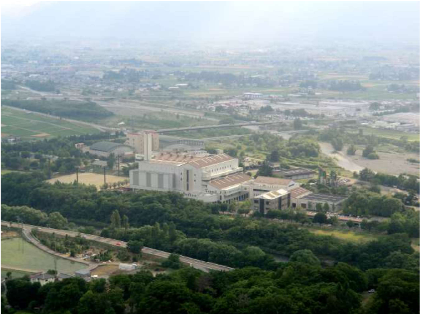
松本クリーンセンター
