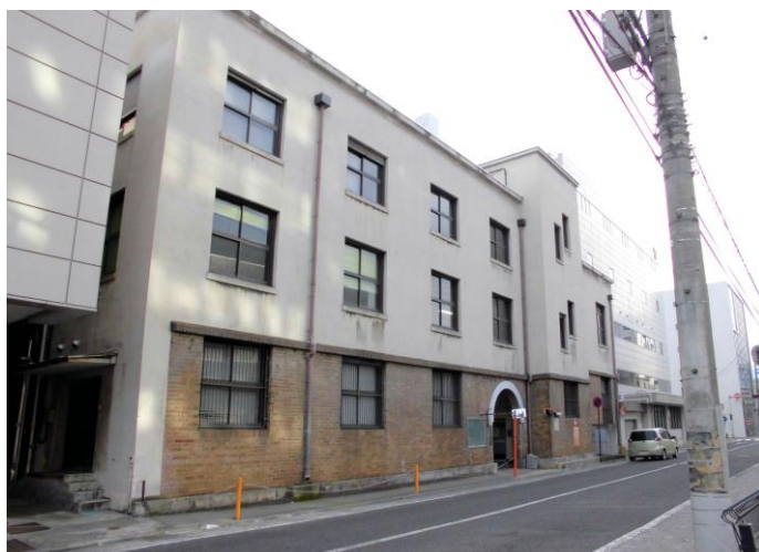
1-04 NTT東日本長野支店大名町ビル
