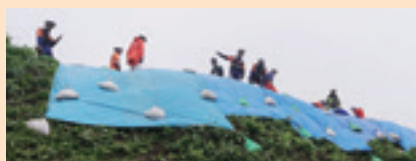
シートや土のうで崩落防止
