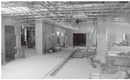
1階内部の様子
