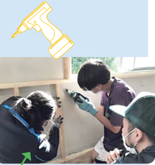
壁に制作した木枠を取り付けます
