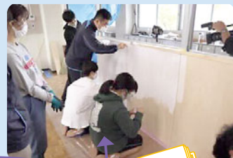
木枠に断熱材のはめ込み塗装までしっかり行います
