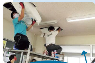
生徒たち自身の手で天井裏に断熱材を敷き詰めます
