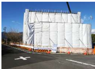
中部縦貫自動車道の橋台工事
