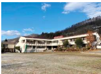
プロポーザル方式により活用事業候補者が決定した旧五常小学校
