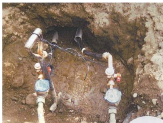
給水管の取替工事
