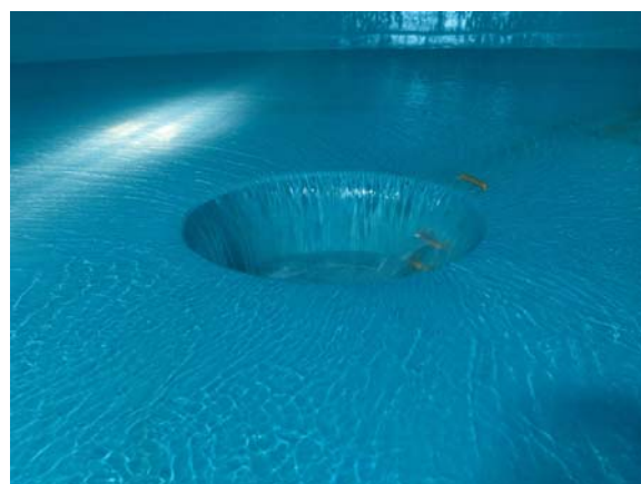
配水池の清掃後の状況
