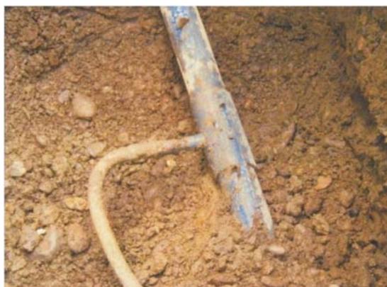
給水管の布設状況
