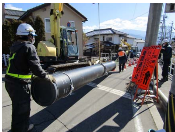
耐震管搬入状況
