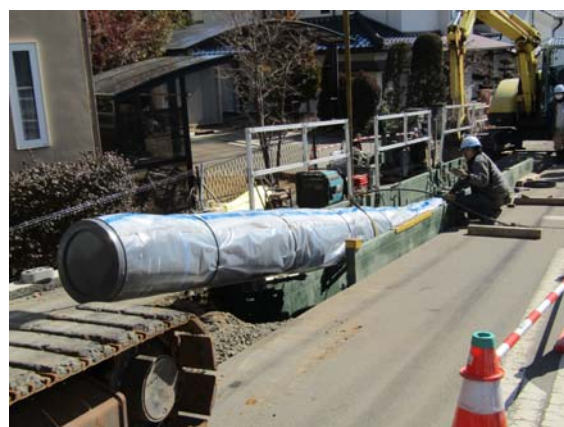
耐震管布設状況
