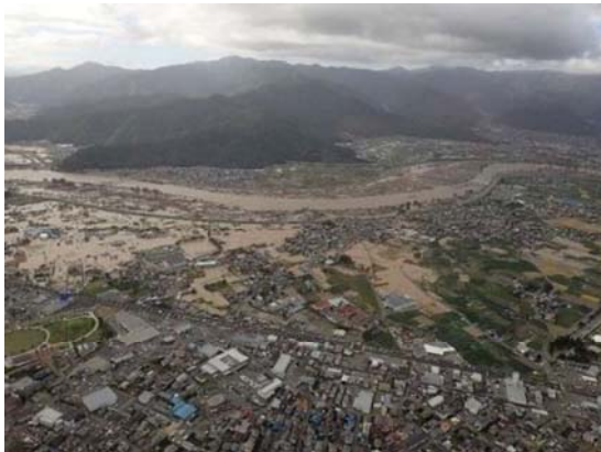
令和元年台風第 19 号による浸水被害（長野市）
