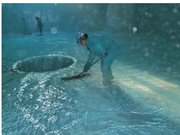
配水池の清掃状況
