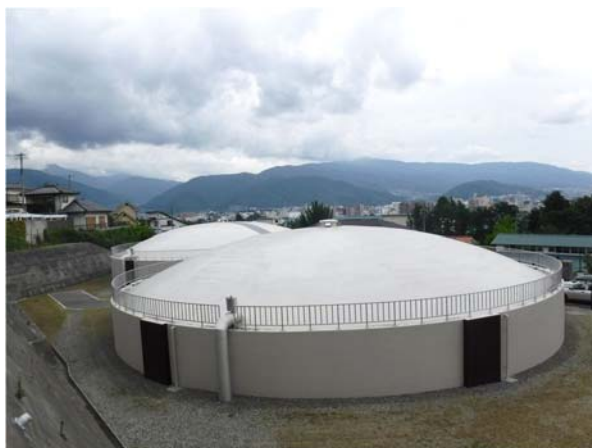
松本地区 蟻ヶ崎配水地
