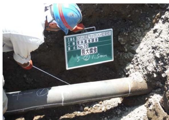
管体腐食度調査
