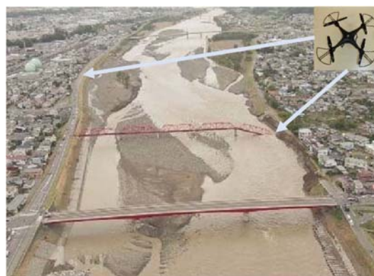
災害現場等、人が侵入できない箇所の確認
