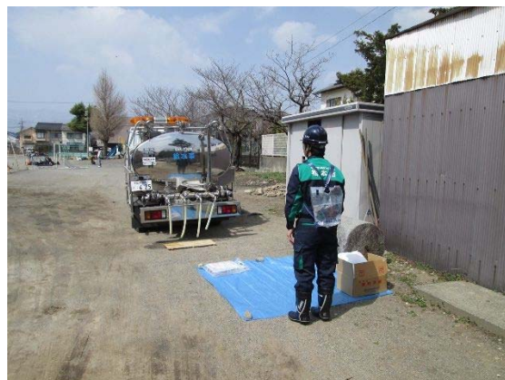
非常用給水袋使用状況
