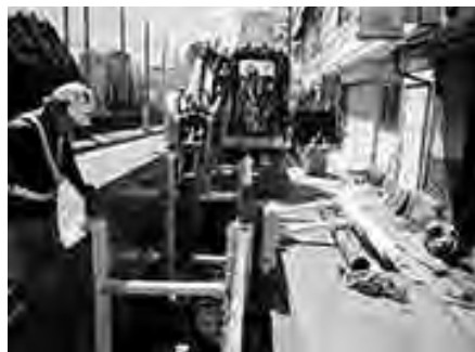
計画的に進む水道耐震化工事
