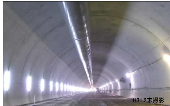
2号トンネル整備状況
