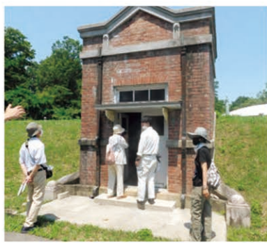
旧城山配水池入口 内部の見学
