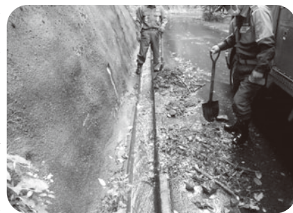
活動の様子① 「大雨警戒時側溝に詰まったゴミの除去」
