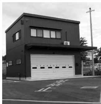
同規模の内田地区消防団詰所
